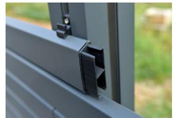
Einfache Montage mit Befestigungsclip und Längsverbinder
